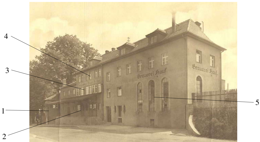
Bild 3: Hauptgebäude der neuen Brauerei
